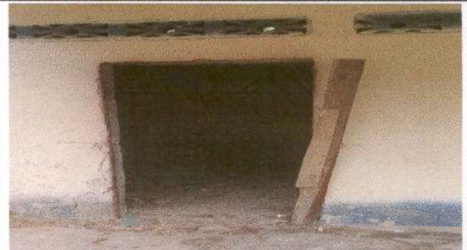
Foto 2: Instalación de sanitario para niñas, puerta de metal.
